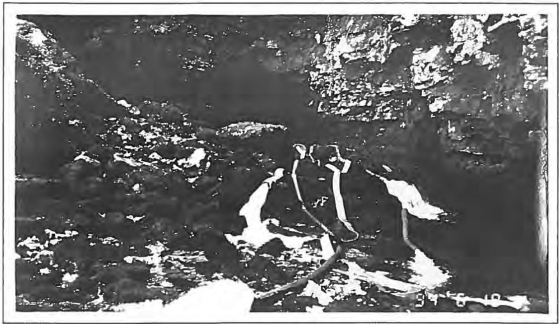
A l'étiage au cours du pompage
