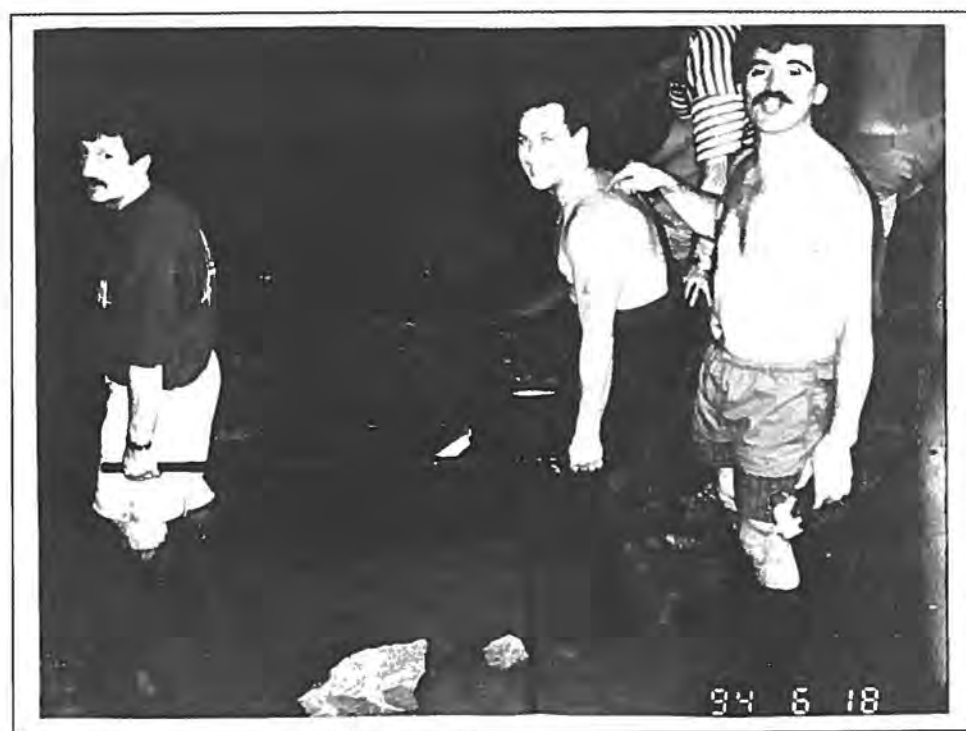
Mise en place des pompes
